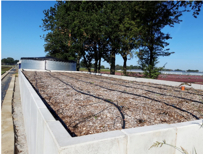
Abbildung 4: Das Substratbeet wurde über Flur angelegt
