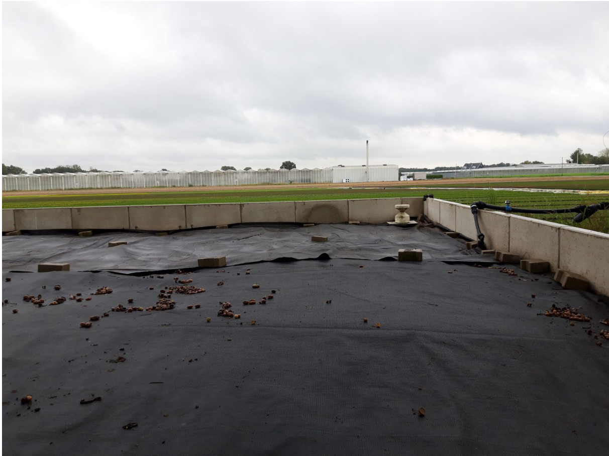
Abbildung 31: Zum Schutz gegen Wildkräuter wurde das Substratbeet Ende 2020 mit einem Gewebetuch abgedeckt.
