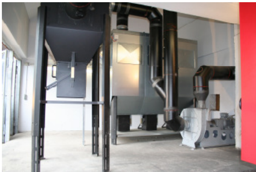
Abgas-Reinigungsanlage mit Multizyklon und Rauchgas-Gewebefilter für 450 kW - Anlage
