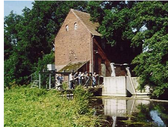
Wasserkraftanlage Hautmann (30 kW)
