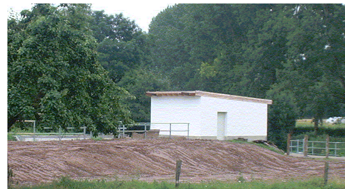
Wasserkraftanlage Holtey (95 kW)
