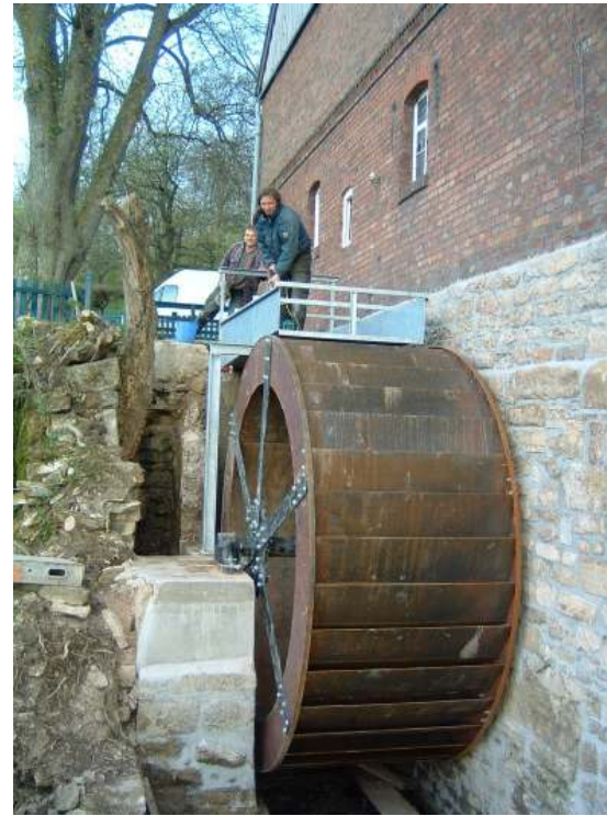
Mittelmühle, Bad Driburg
