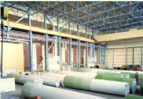
Turmfertigung (Stahl und Beton) 5 Werke weltweit
