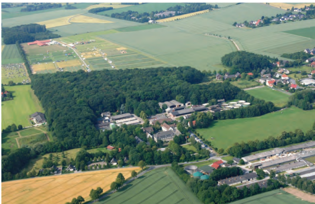
Abbildung 2: Blick auf Haus Düsse aus Richtung Süden
