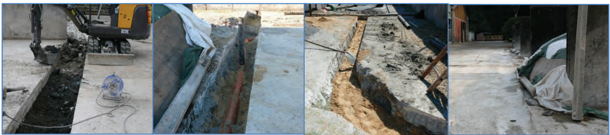
Abbildung 14: Sanierung und Abdichtung der Siloanlagen
